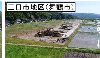
地盤改良・樋門の新設を実施
