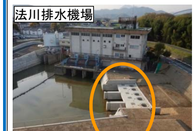
ポンプ・発電機棟の工事を実施 (緊急排水ポンプ12.0m 3 /s)
