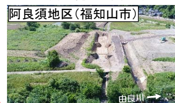
地盤改良・樋門の新設を実施
