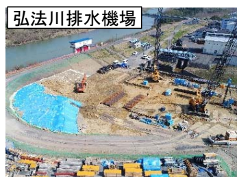
排水機場の本体工事を実施 (常設ポンプ9.0m 3 /s)
