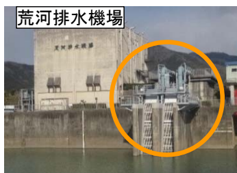
緊急排水ポンプ(3.0m 3 /s) 増強ポンプ完成(H28.9)
