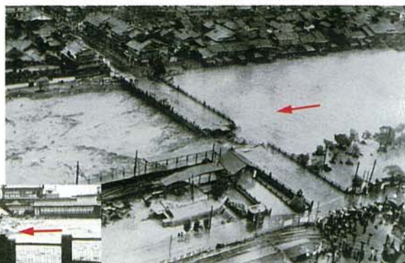
▲三条大橋の流失状況
