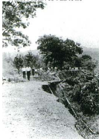
▼御園橋下流右岸側の被災状況
