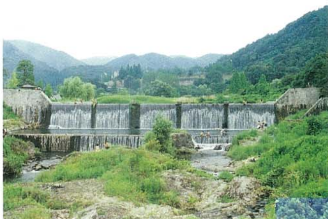
▲ 杵野堰堤 (ひいらぎのえんてい) 昭和10年の災害を機に上流からの土砂を抑制するために構築されました。
