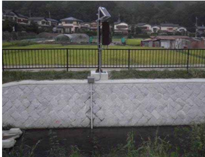
水位計の設置事例（長代川）
