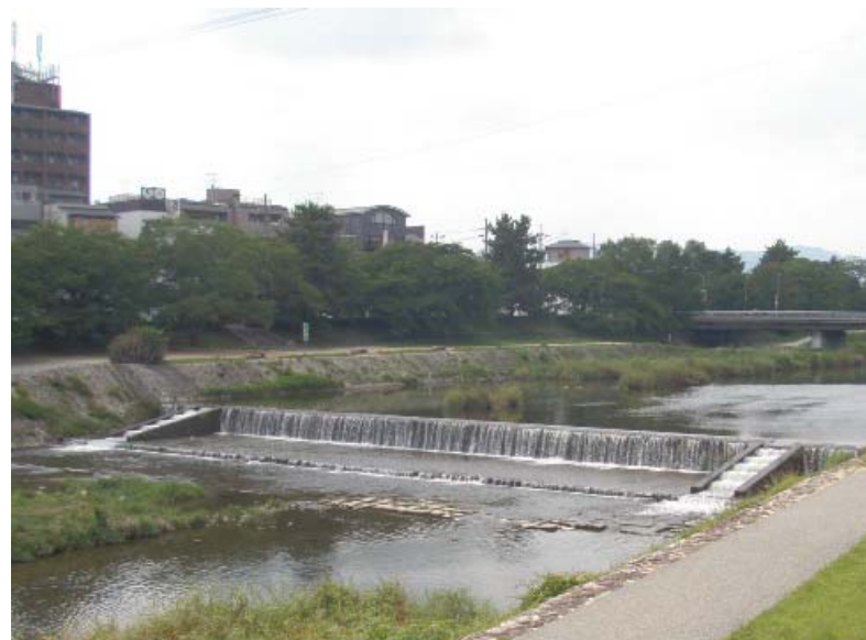
出町橋上流の落差工に設置された魚道
